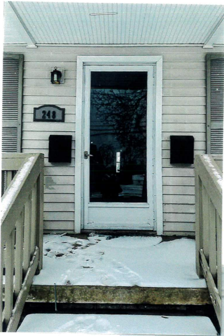
Front Storm door
