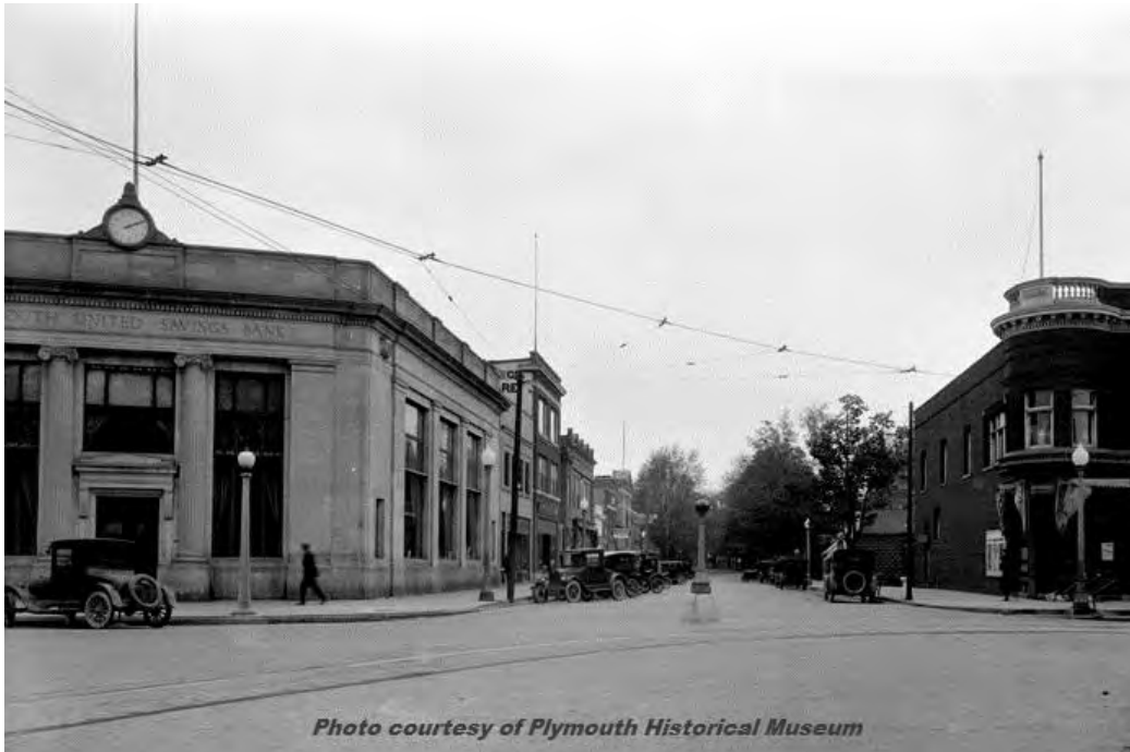
Corner of S. Main St. & Penniman Ave.
