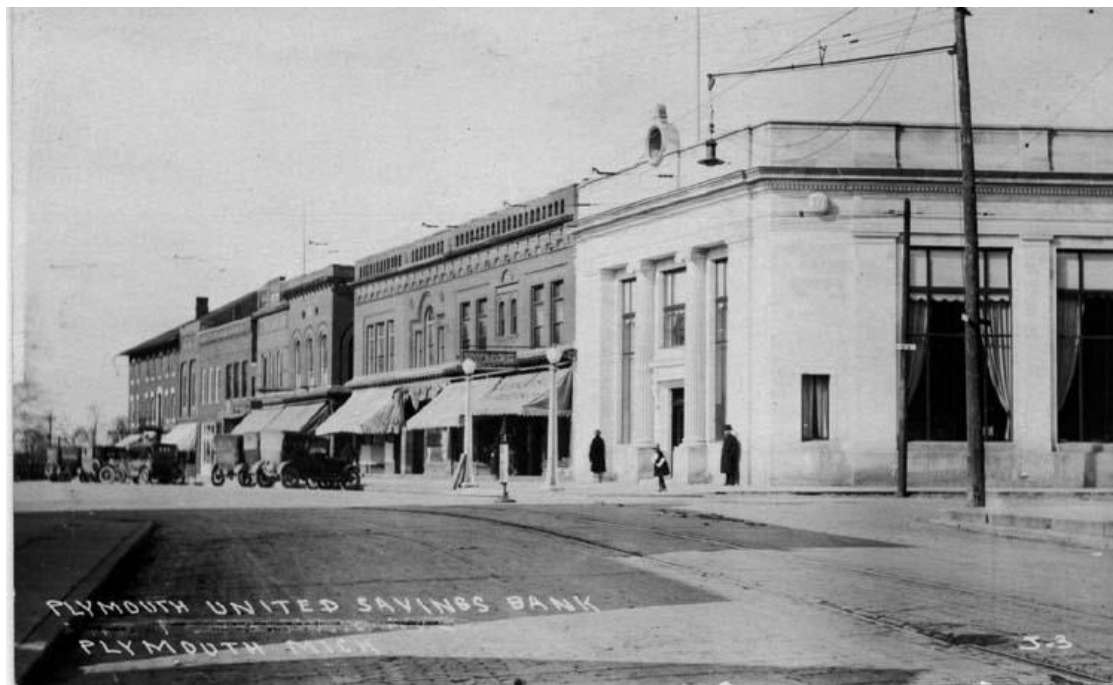
Corner of S. Main St. & Penniman Ave.
